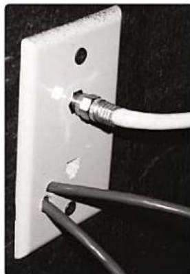
Gambar II.7. Lubang di Dinding Diberi Tutup (Sumber : Wahana Komputer;2010;25)
