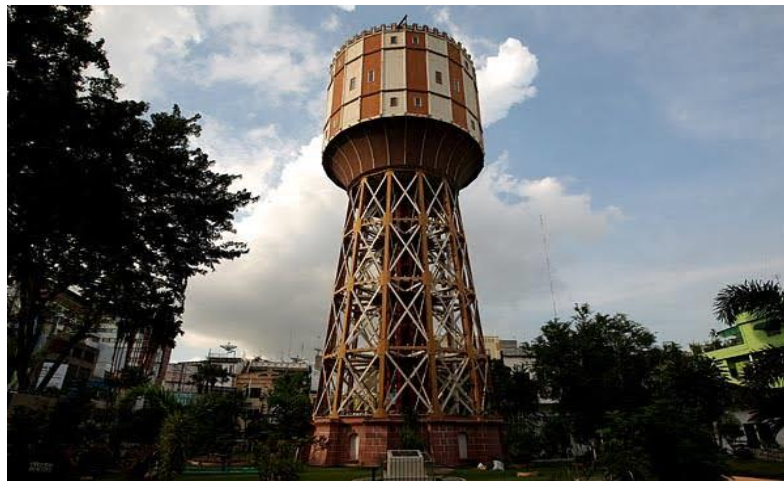
Gambar 3.1.2 1 Bangunan Menara PDAM Tirtanadi tampak dari depan (Sumber: Rizky Prayuda, 2023)
