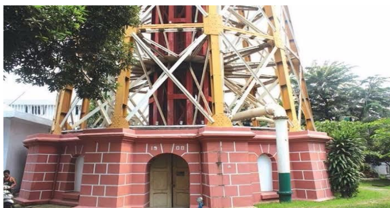
Gambar 3.1.2 2 Bangunan Menara PDAM Tirtanadi tampak dari bawah (Sumber: Hariananalisedaily, 2018)
