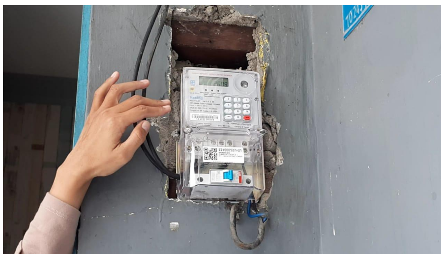
Gambar II. 3 Internbal Meteran di Modifikasi
