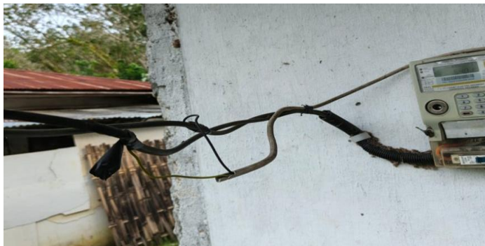
Gambar II. 5 Sambungan Ilegal pada Meteran listrik
